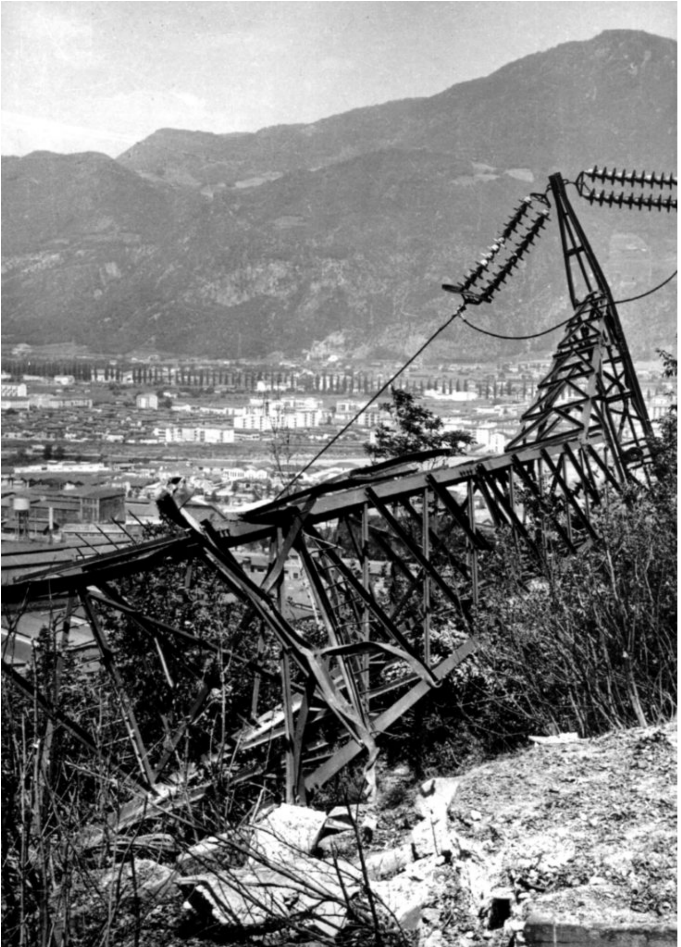
In der „Feuernacht“ von 1961 gesprengter Mast
