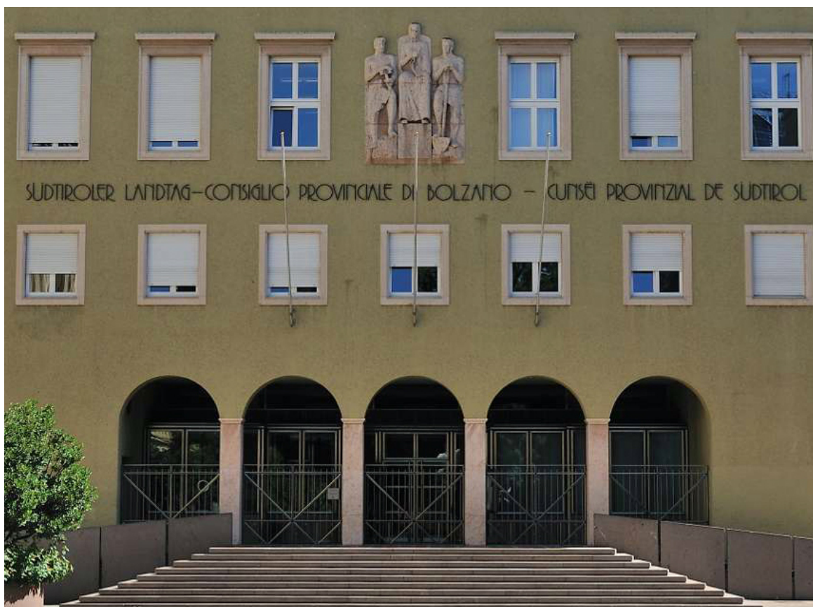
Portal des Südtiroler Landtages in Bozen
