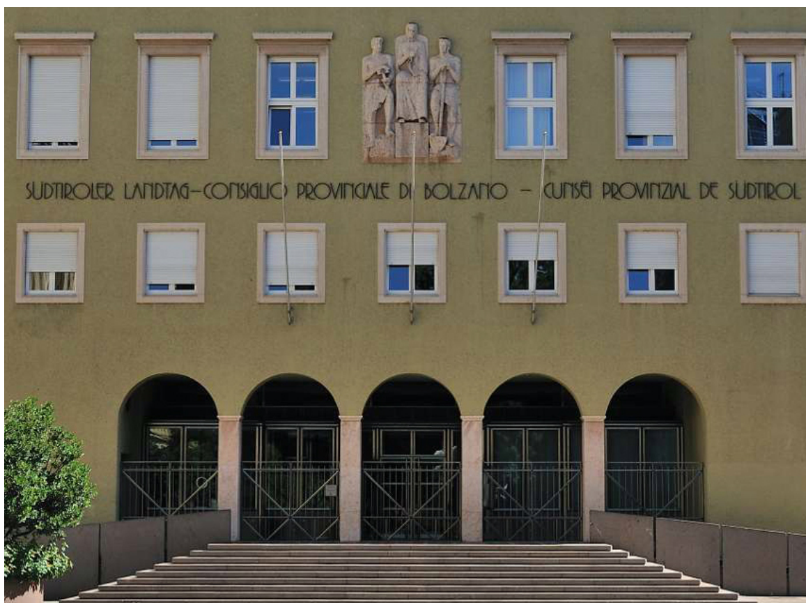
Portal des Südtiroler Landtages in Bozen
